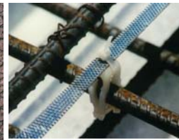
Titanium Ribbon Mesh ขั้วแอโนดชนิด ribbon
