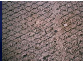
Titanium Anode Mesh ขั้วแอโนดชนิด mesh
